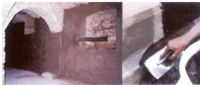
ГИДРОИЗОЛЯЦИЯ КАНАЛОВ, ШАХТ И ТУННЕЛЕЙ
