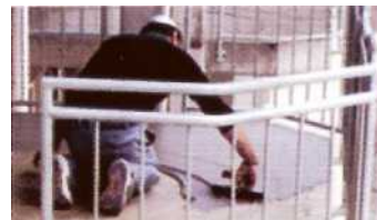
ГИДРОИЗОЛЯЦИЯ ПОД КЕРАМИЧЕСКОЙ ПЛИТКОЙ
